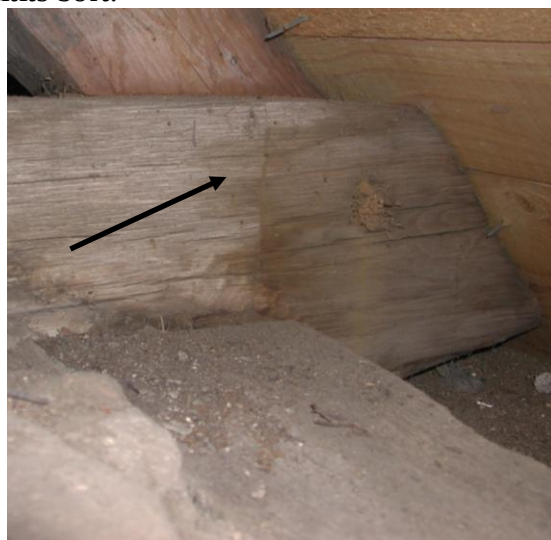
Bild nr 12. Pilen visar bindbjälkens norra rits som markerat underhuggets utsida. Foto J Mårtensson.
