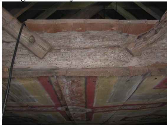
Bild nr 21. Här en av de mest illa åtgångna bindbjälkarna.
