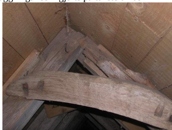
Bild nr 24. Förstärkning av den sönderhuggna och senare rötskadade takstolen. Foto J Mårtensson.
