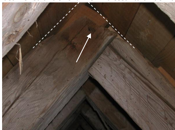
Bild nr 23. Ursprunglig nockprofil samt nagelns placering. Foto J Mårtensson.
